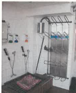
Abbildung 110: ROT- Bereich mit Trocknungsanlage
