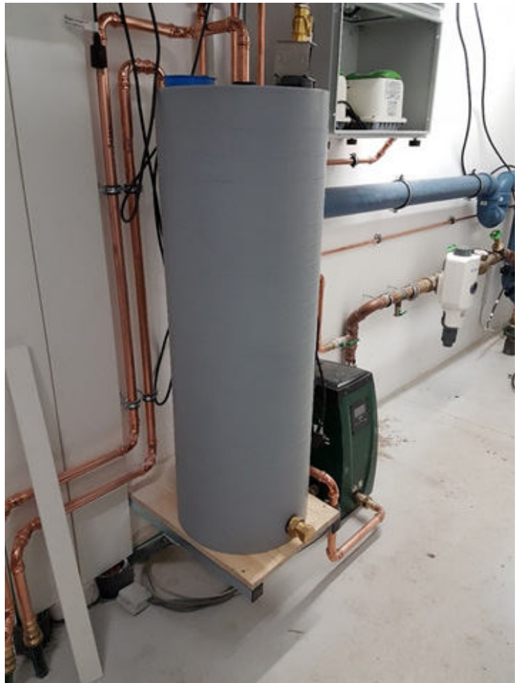
Grauwassernutzungsanlage im Wohnhaus (im Bauzustand, Quelle: BUB)
