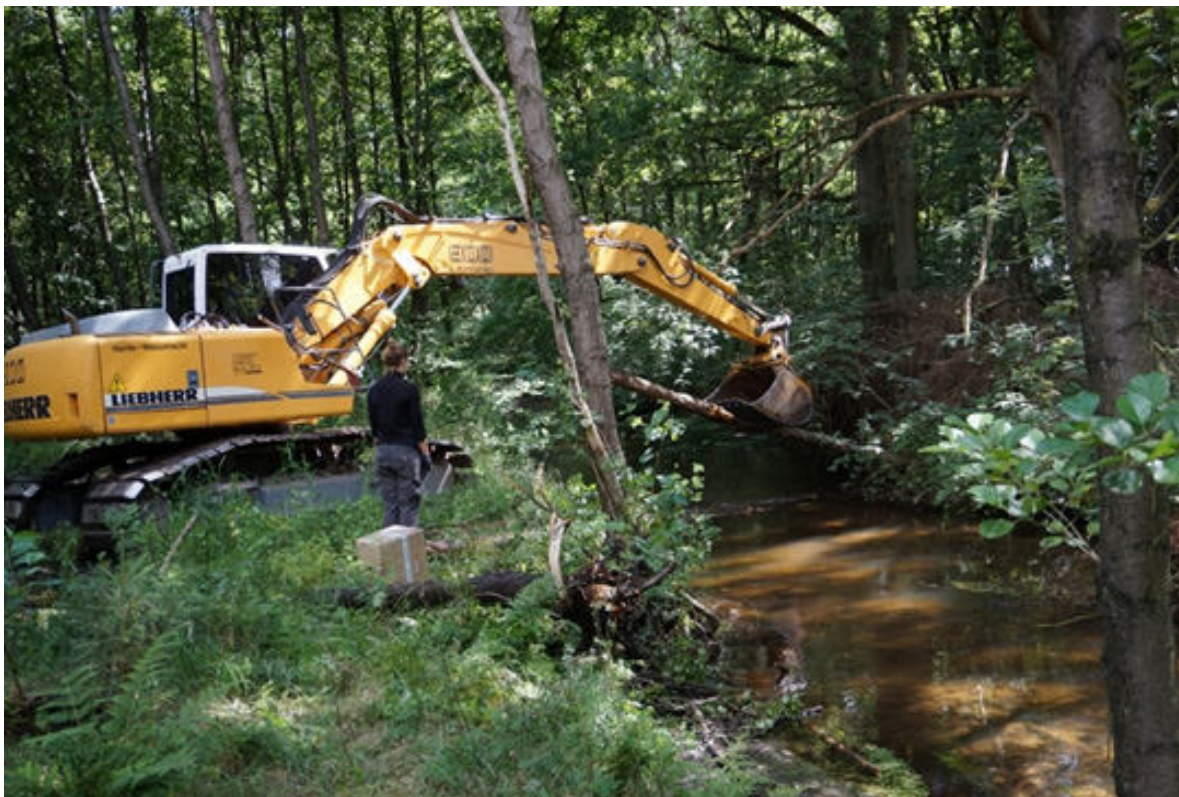
Naturnahe Gewässerentwicklung: Verbesserung der Abflussverhältnisse an einem norddeutschen Tieflandbach durch Einbringen von Gewässerstrukturelementen. Das Foto zeigt die Umsetzung und fachliche Begleitung der Maßnahme (Quelle: SUKW)
