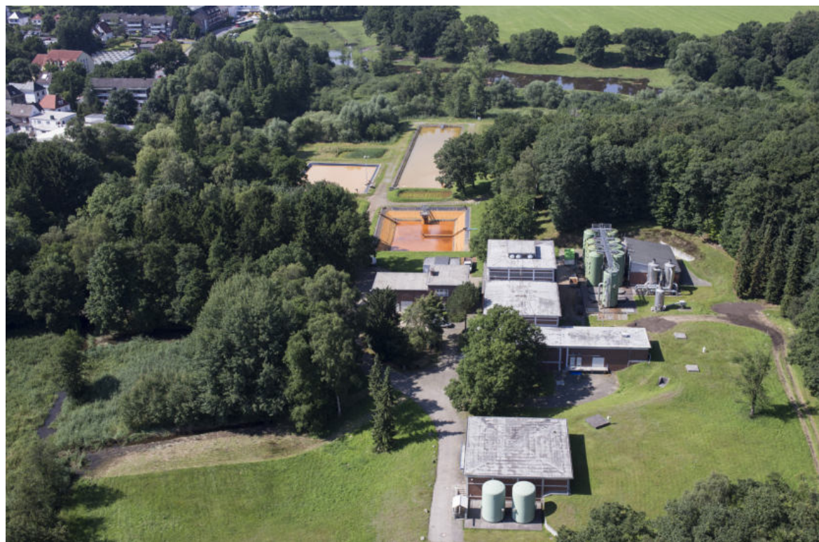
Wasserwerk Blumenthal (swb AG)
