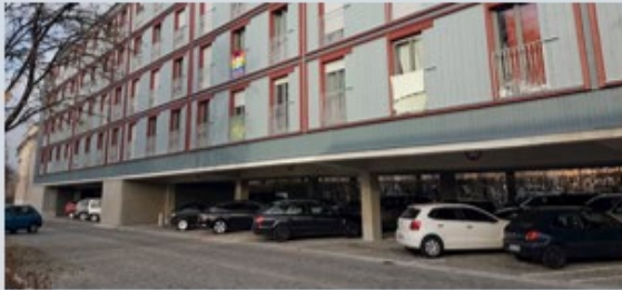
Abb. 33 Nachträgliche Überbauung eines Parkplatzes in München durch geförderten Wohnungsbau Quelle/Foto: Martin Randelhoff @ QIMBY.net – CC0 1
