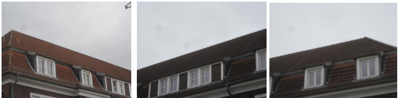
Abbildung 4: Blick auf das Schrägdach mit den Gauben
