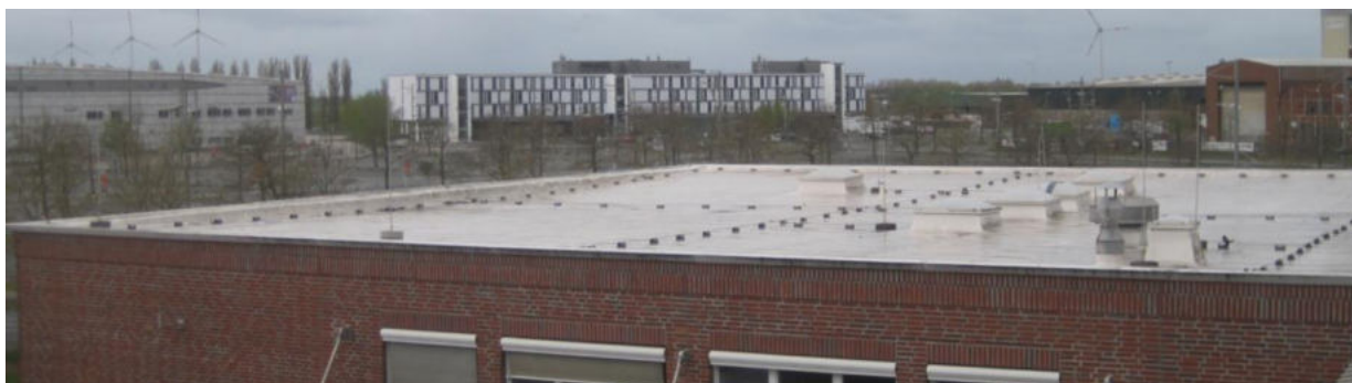
Abbildung 5: Blick auf das Hallendach
