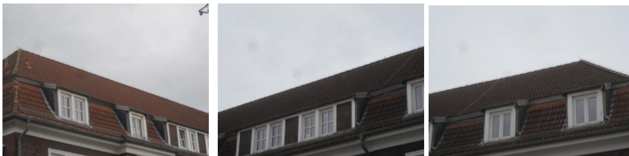
Abbildung 4: Blick auf das Schrägdach mit den Gauben
