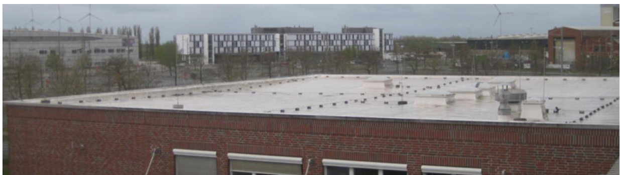
Abbildung 5: Blick auf das Hallendach
